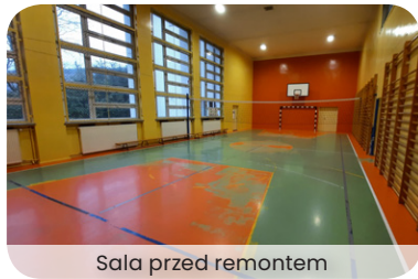
Sala przed remontem
