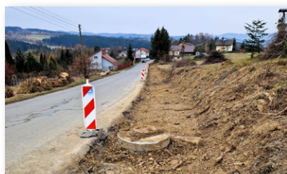
Budowa chodnika w Mystkowie
