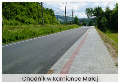
Chodnik w Kamionce Małej
