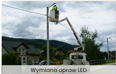
Wymiana opraw LED
